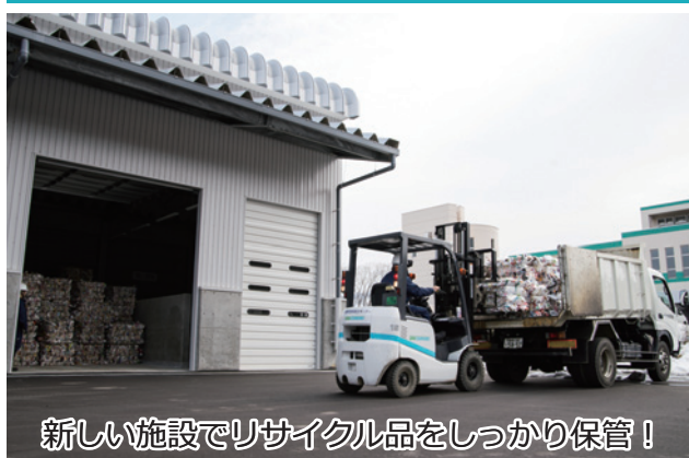
ストックヤード（平成29年1月稼動）
