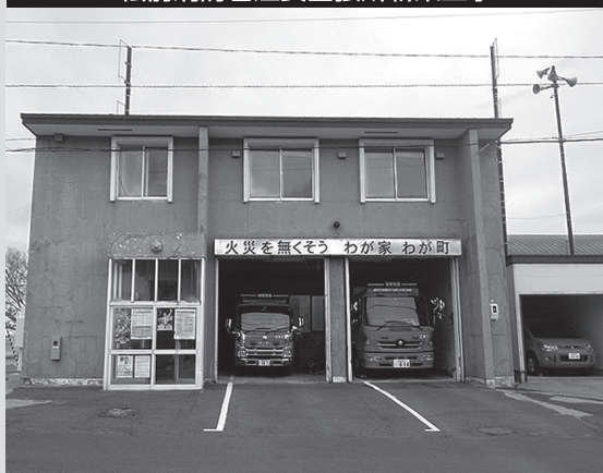
松前消防署江良出張所新築工事
